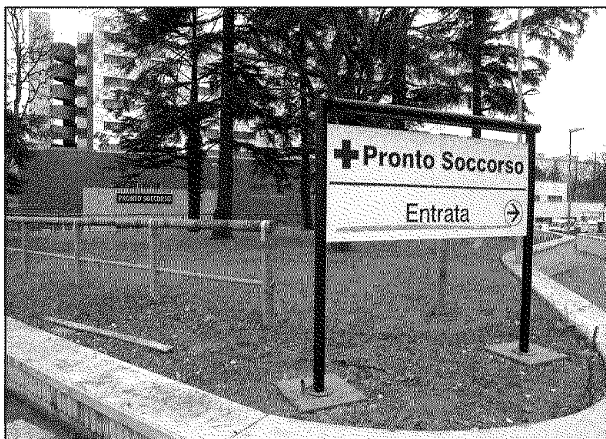
Presenza di Bartolini sui lavori per la strada del Pronto soccorso
